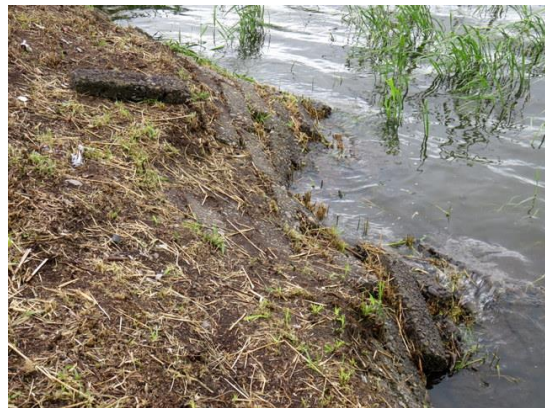
B地点生振 岸から（平成28年）
