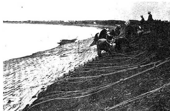
護岸工事施工の光景 (殖民公報第 109 号)
