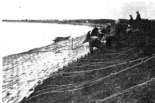
護岸工事施工の光景 (殖民公報第 109 号)
