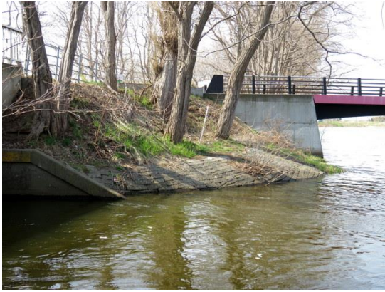
D地点 観音橋近辺（平成28年）
