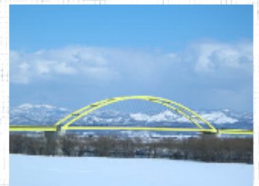
3月26日開通した美浦大橋
