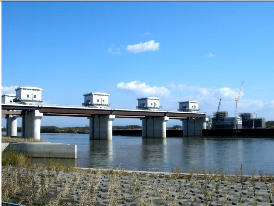
1+) 岩見沢市-月形町; H=4.6m; L=257m; 2013年(予定) 建設中・新石狩川頭首工 2010.10.29
