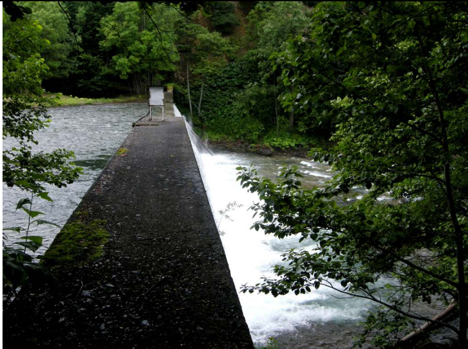
17) 河口から237km(石狩平水位観測所)・上川町; H= ?m; L= ?m; ?年
