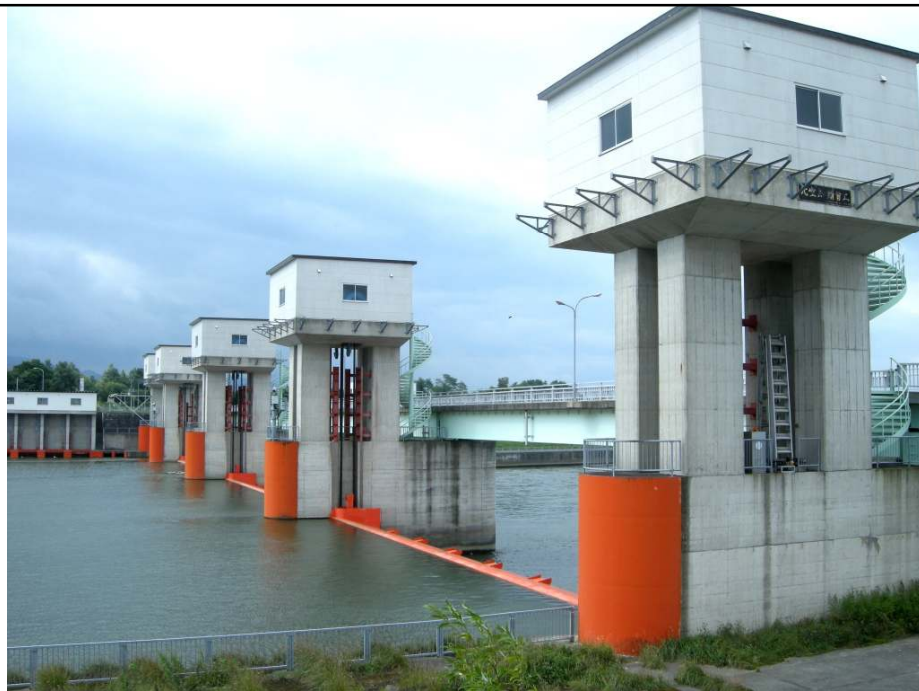
3) 河口から125.2km・深川市; H=4.9m; L=141.3m; 1986年
